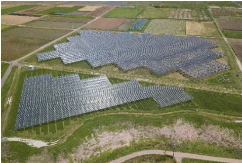
DC 1.2 MW APV
